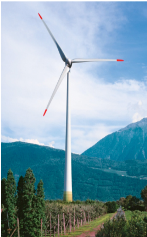
Eolienne proche de Martigny
