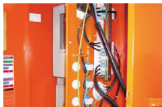
Porte intérieure pour accès facile aux câblages
