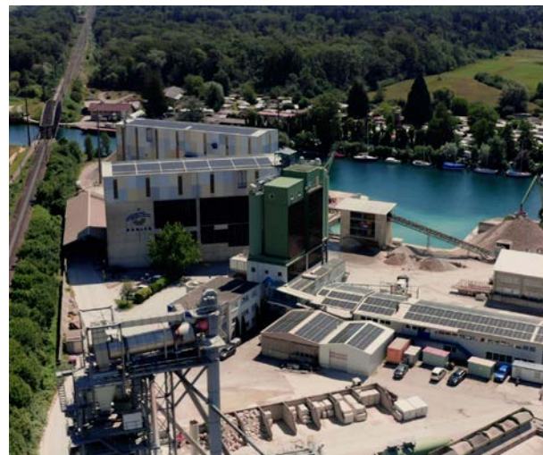
Centrale solaire sur le site Holcim de Marin
