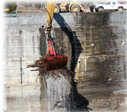
Récupération de bois sur un barrage
